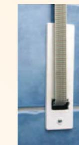
Popruh nebo klika jsou vedené mimo okno, takže odpadá vrtání otvorů do rámu nebo skrz rám okna. Při manuálním ovládání je potřeba do zdi zabudovat pouzdro navijáče a průchodku popruhu (u rolety) a průchodku kliky (u žaluzie).
