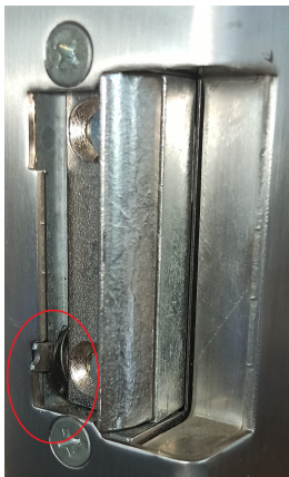
Páčka určená k přepínání elektrozámku do trvale otevřené polohy
